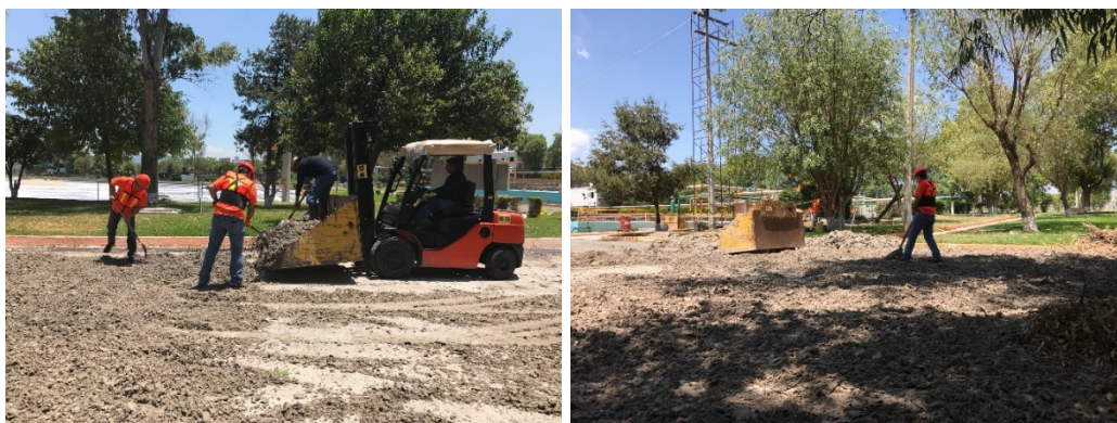
Figura 10: Extendiendo y volteando los lodos
